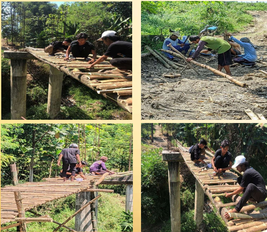
Gambar 1. Proses Pembangunan Jembatan
